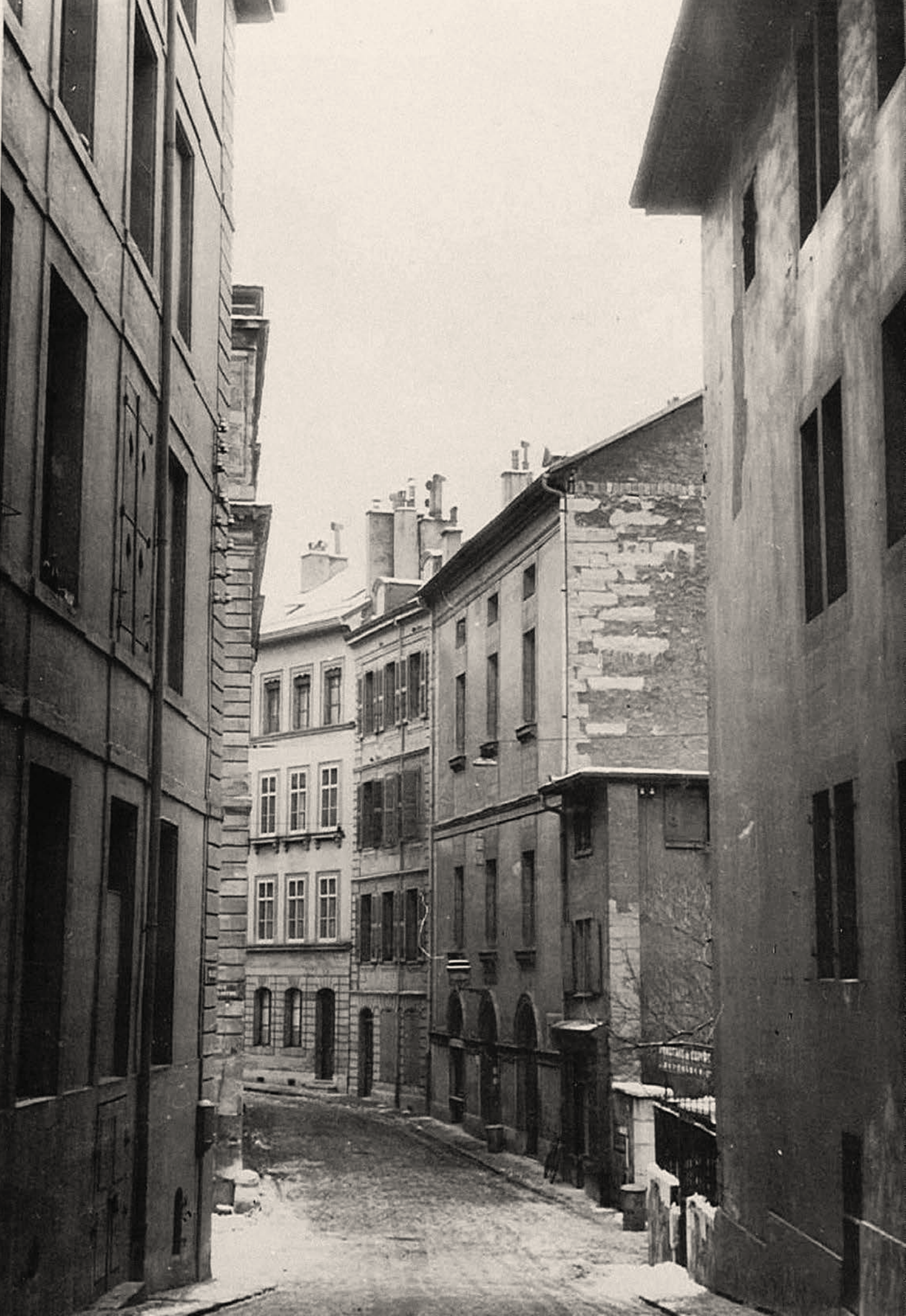
1, rue de l'Évêché, immeuble géré par la régie depuis 1869
